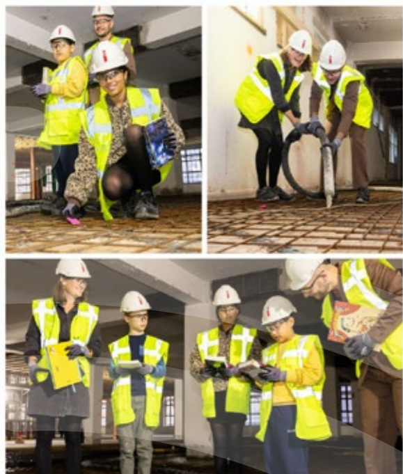
▼ Storten van de betonnen vloer in Magazijn De Zon. Foto's: Juri Hiensch
